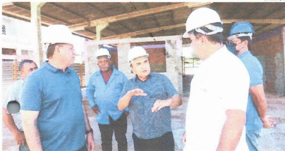
Representando o governo do Estado, Sebastião Madeira visitou obras no município de Loreto
